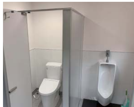
境内トイレ改修
