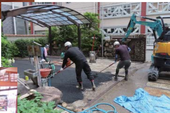
駐車場アスファルト舗装
